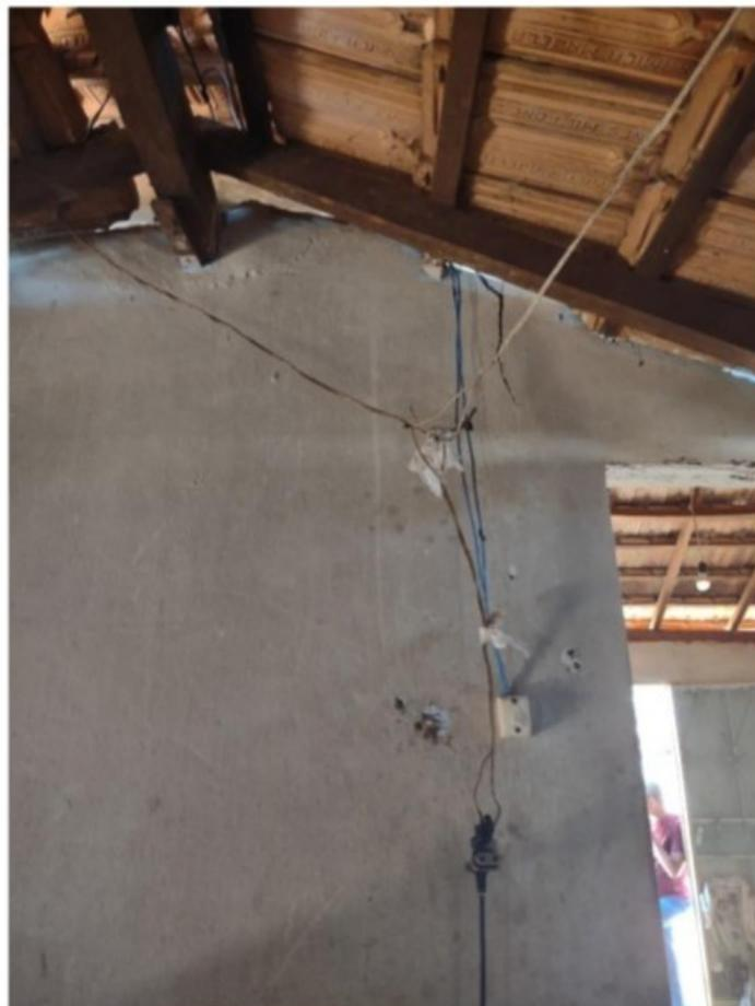
**Imagens:** Instalações elétricas improvisadas e com emendas e chuveiro com partes vivas expostas.
