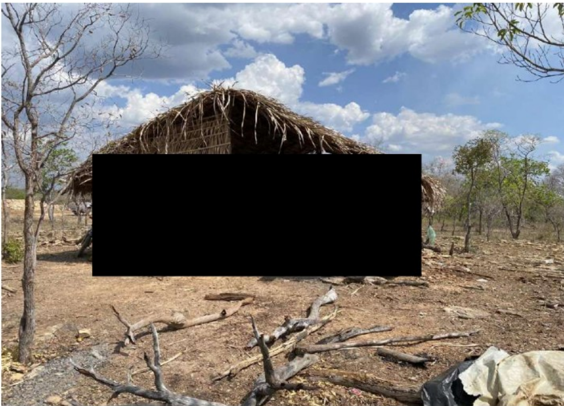
Alojamento dos trabalhadores
