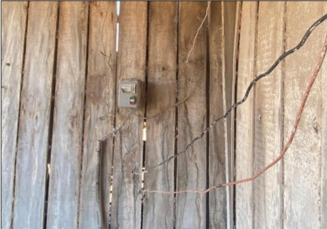
Imagem acima: Instalações elétricas precárias na área de preparo de ração.
