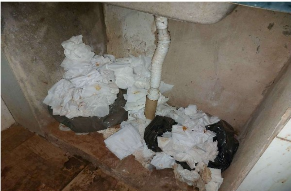
Figura 15: instalação sanitária no alojamento da Rua [REDACTED] s [REDACTED]
