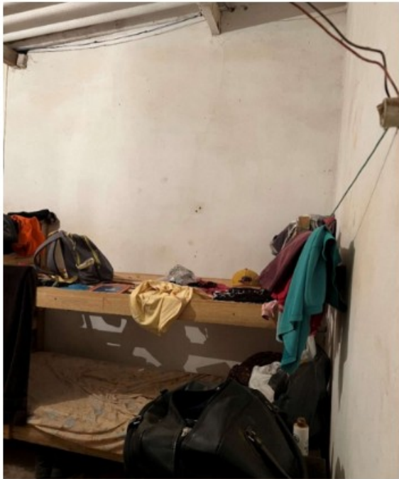
Figura 11: Instalação elétrica inadequada no interior de dormitório; Figura 12: Circuito elétrico improvisado a partir do ponto de chegada (poste) de energia do alojamento localizado na Rua [redacted]
