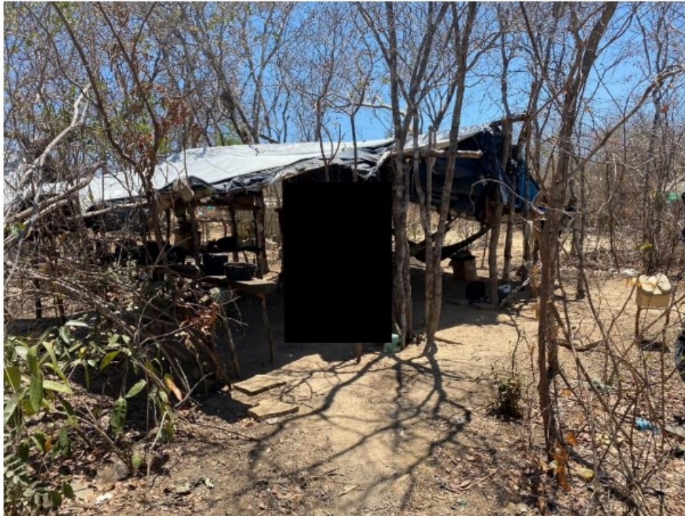
Foto 04: barraco rústico que servia como acomodação para alguns dos trabalhadores encontrados no estabelecimento fiscalizado.
