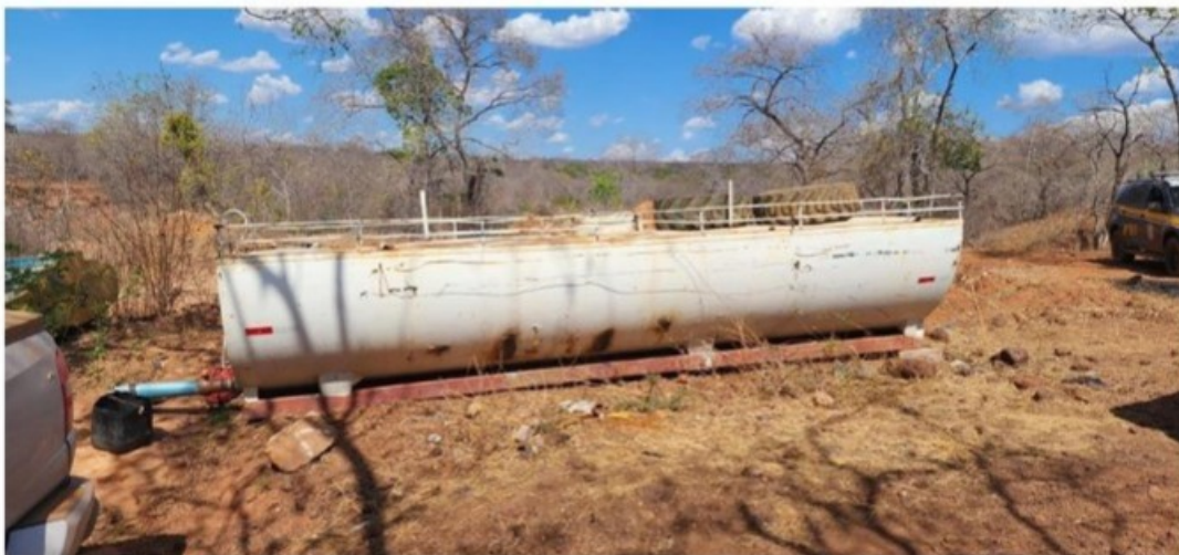
PIPA ONDE ERA ARMAZENADA A ÁGUA DE CONSUMO DOS TRABALHADORES
