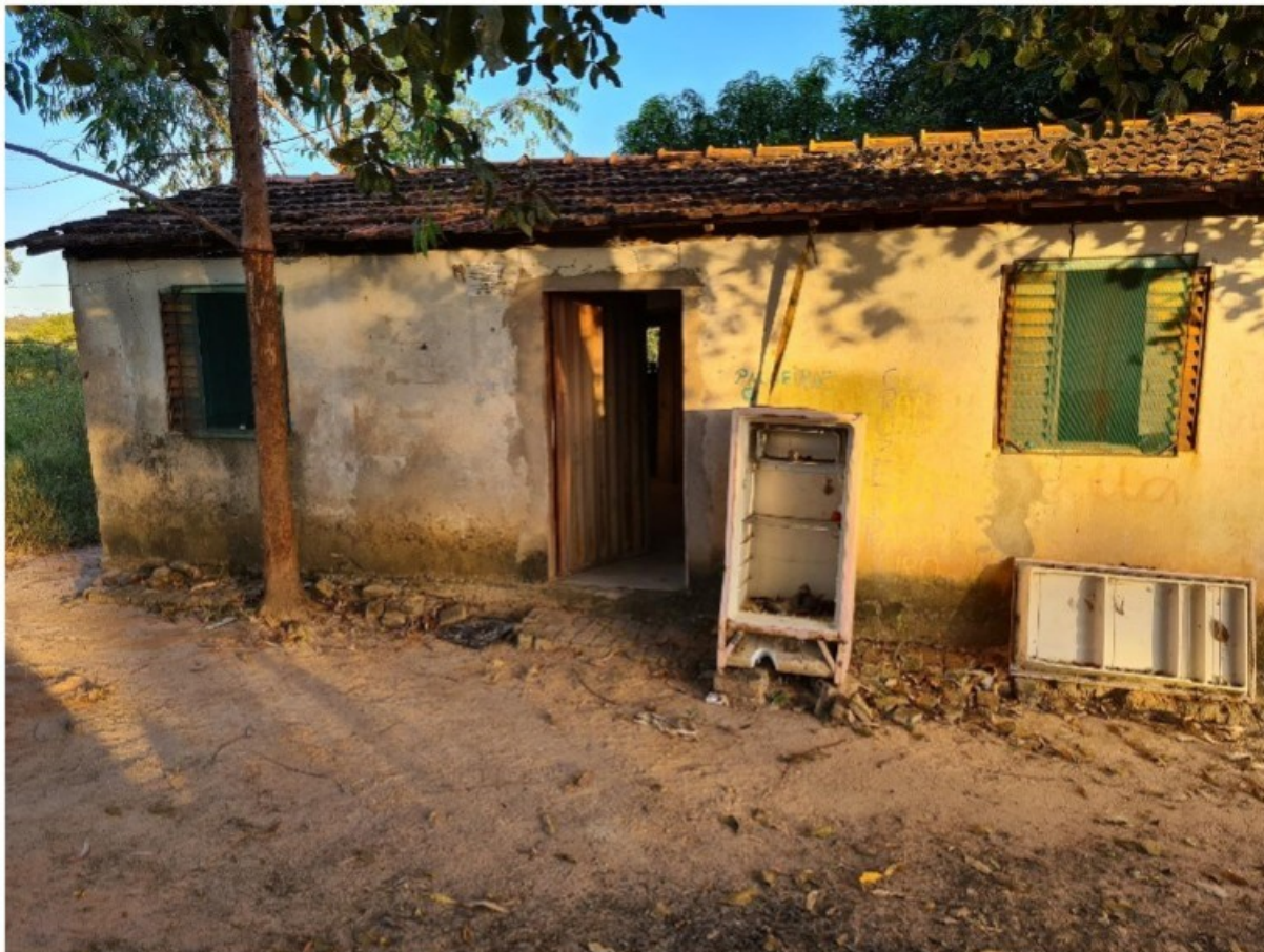
Foto 3. Vista externa da edificação utilizada como alojamento. Registro fotográfico efetuado em 06/04/2022.
