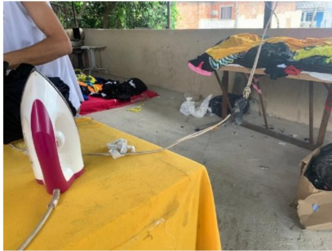
Fiação com emendas precárias
