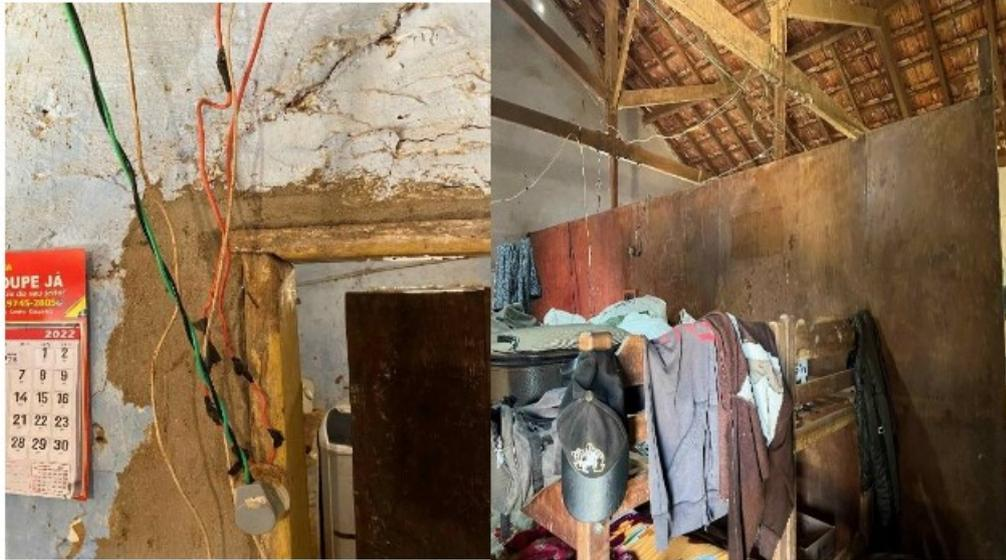
**Figuras 12 e 13: instalações elétricas inadequadas.**
