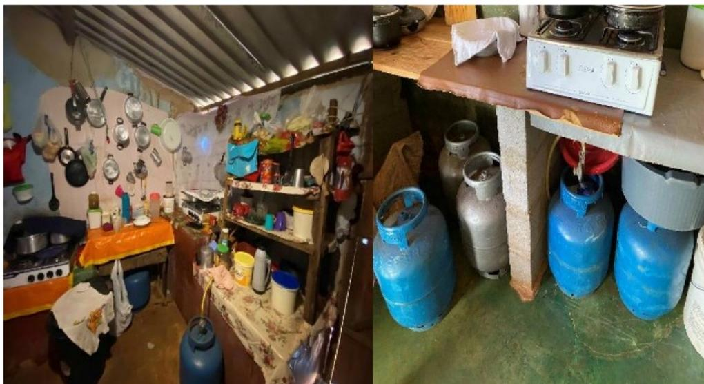
**Figura 4 e 5: recipientes de armazenagem de GLP no interior das edificações**
