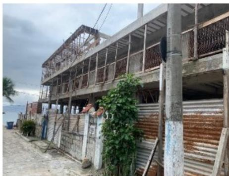
Em inspeção na obra foram identificadas algumas irregularidades, como falta de proteção coletiva nas escadas de acesso aos andares da edificação, falta de proteção coletiva na periferia da edificação, falta de proteção dos vãos do poço dos elevadores, falta de aterramento elétrico da betoneira, ausência de dispositivos de segurança na serra circular, falta de local adequado para refeições com mesas e cadeira, que foram objeto de autuação e regularização do curso da ação fiscal.
