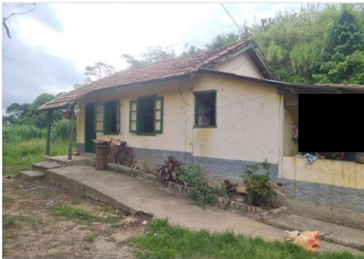
Foto 3: vista frontal da casa do trabalhador
