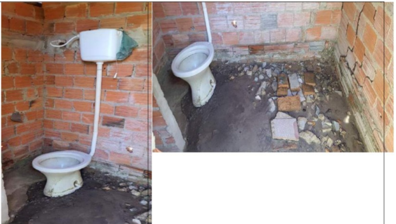
Instalação sanitária em desuso
