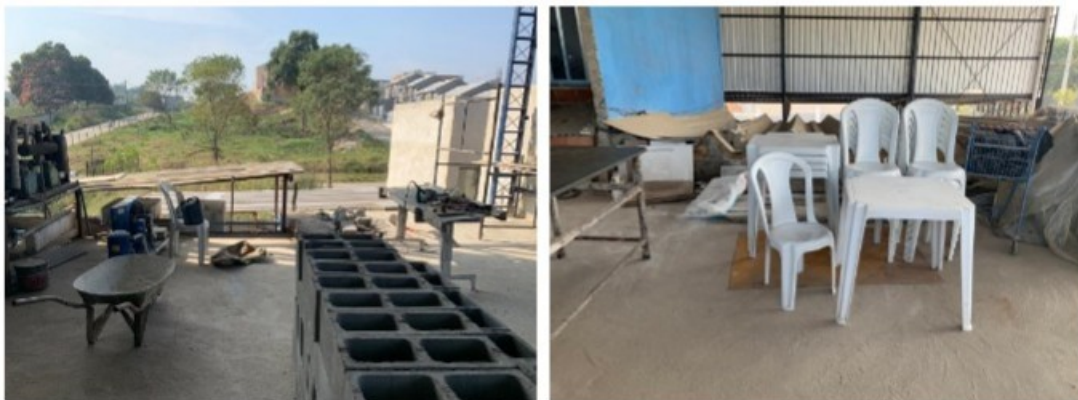
Refeitório em construção
