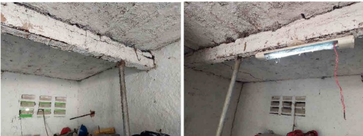
Figura 9 e 10 Escoras de sustentação do dormitório.
