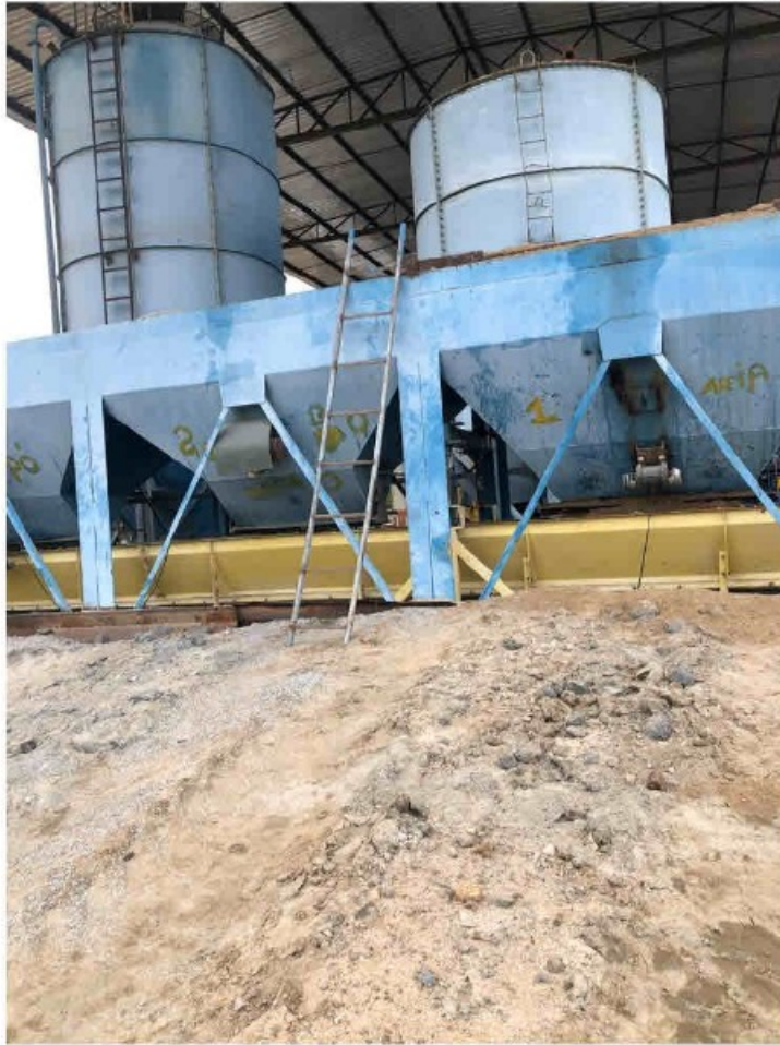
Figura 3 Risco queda em altura.
