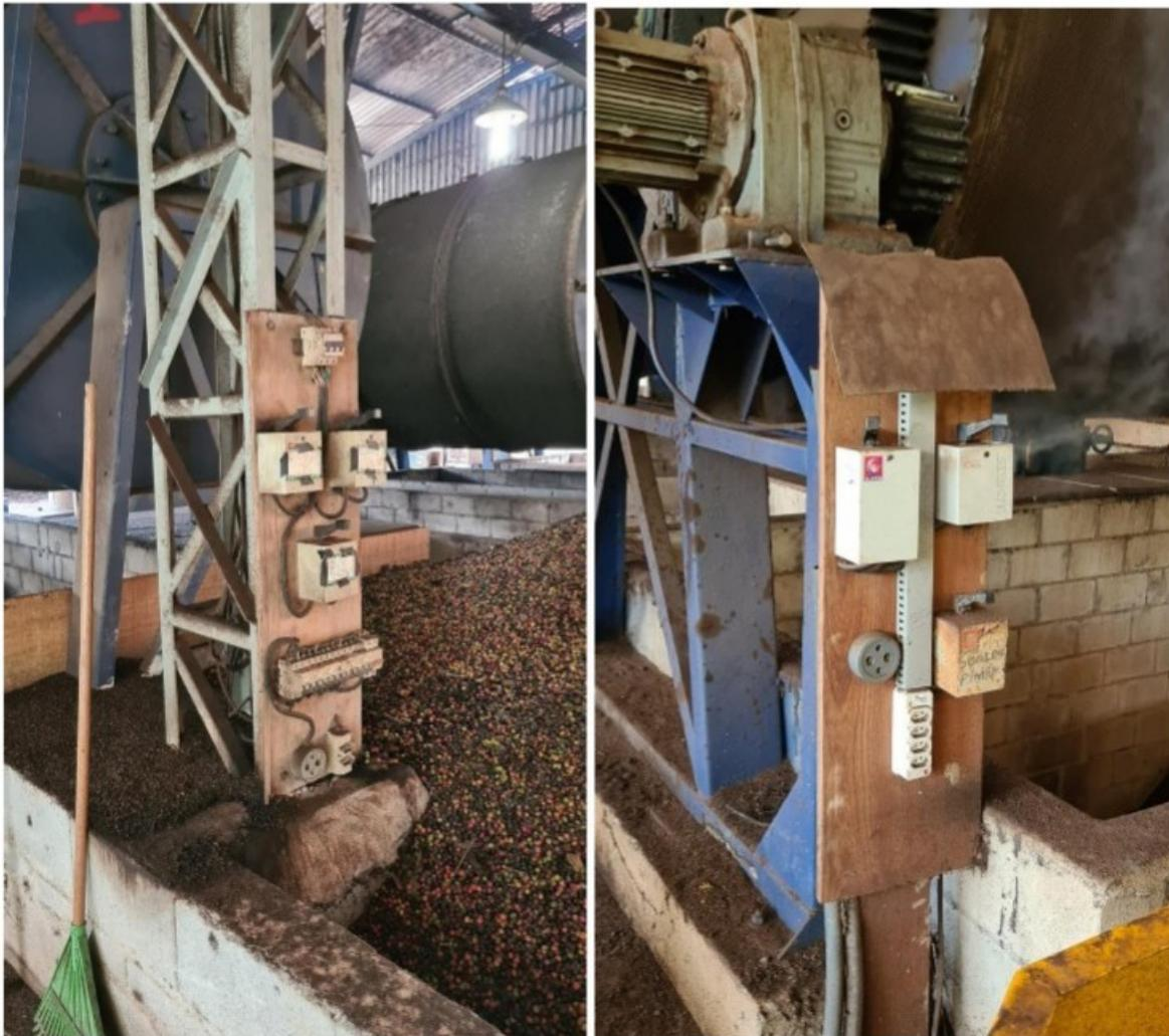
**Foto 9 e 10: Fotos da chaves Lombardi utilizadas no secador de café**
