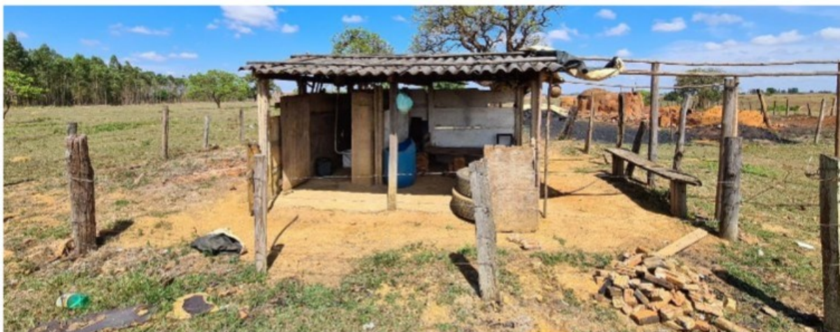
Imagem 4. Construção que abrigava a instalação sanitária da frente de trabalho. Registro fotográfico efetuado em 24/10/2022.
