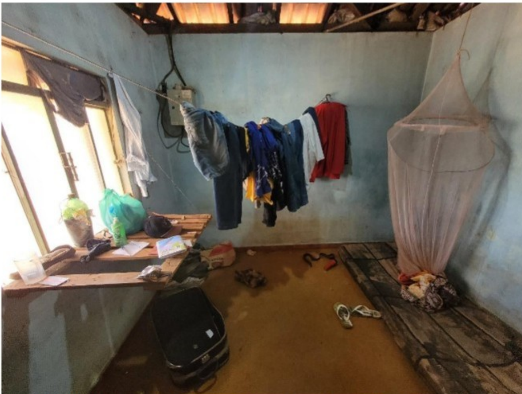
Imagem 13. Quarto utilizado por Francisco. Pedacos de papel eram utilizados para vedar, de forma improvisada, frestas existentes entre as telhas e a parede. Ausência de cama e de armário para guarda dos pertences do trabalhador. Registro fotográfico efetuado em 24/10/2022.
