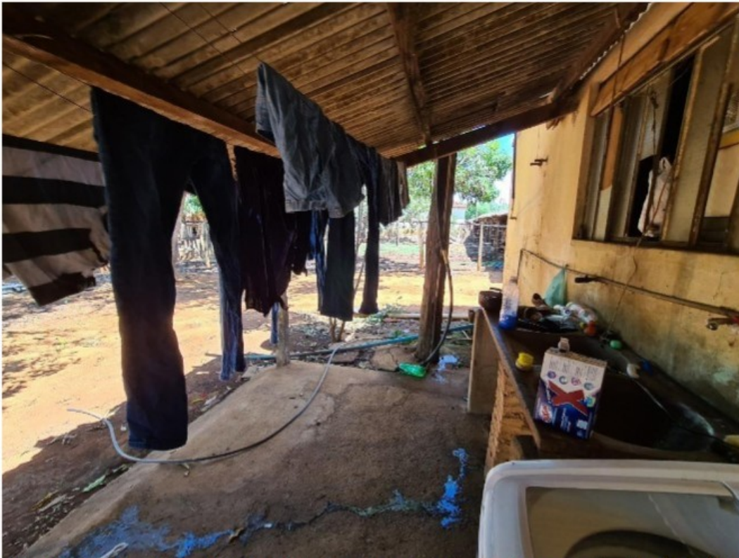
Imagem 14. Vista da lavanderia do existente na parte posterior do alojamento. Registro fotográfico efetuado em 24/10/2022.
