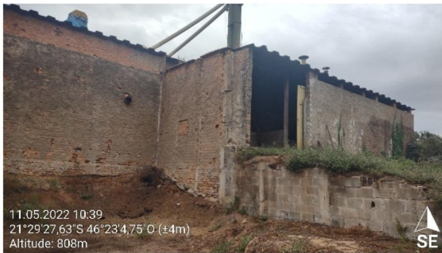
Foto 7 : Edificação onde fica o secador de café
