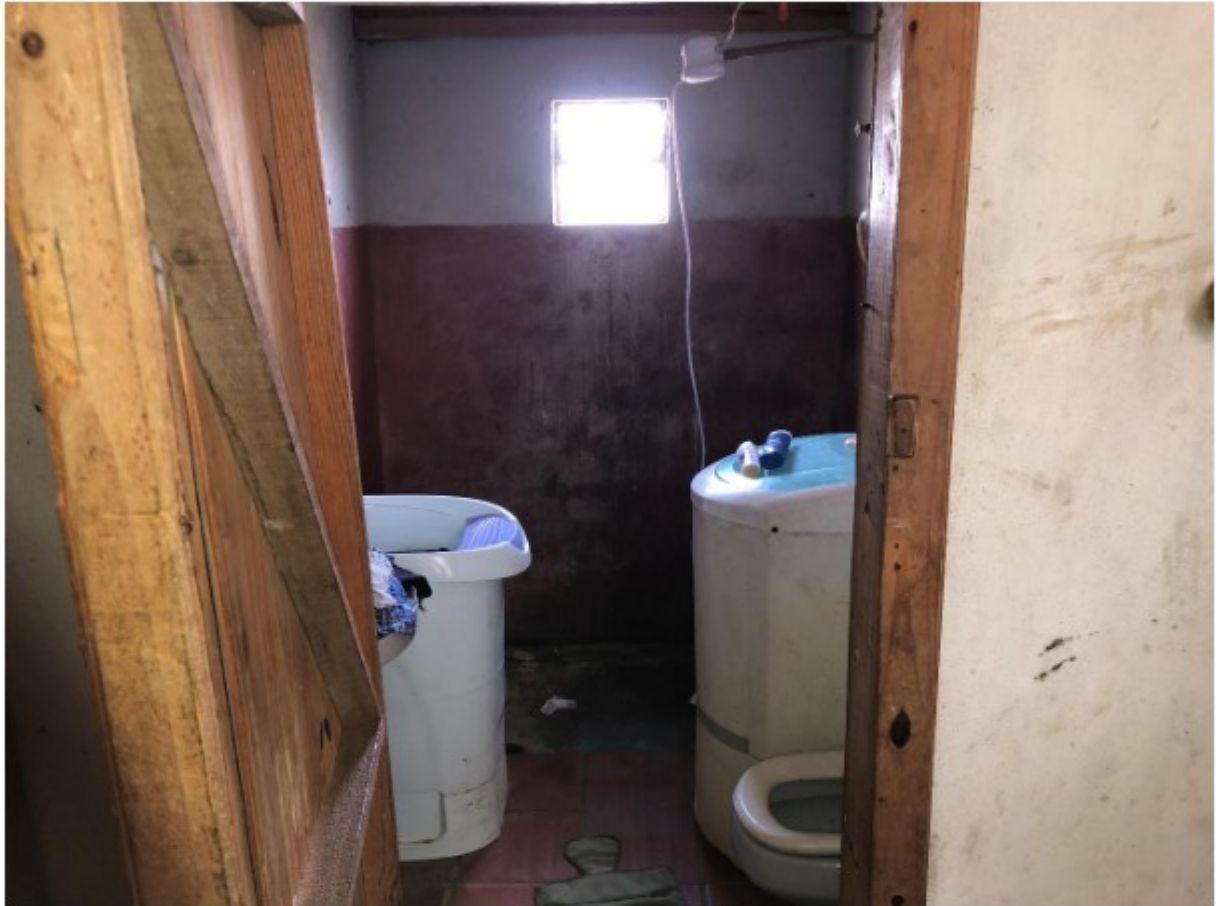
Figura 2 - Instalação sanitária da moradia
