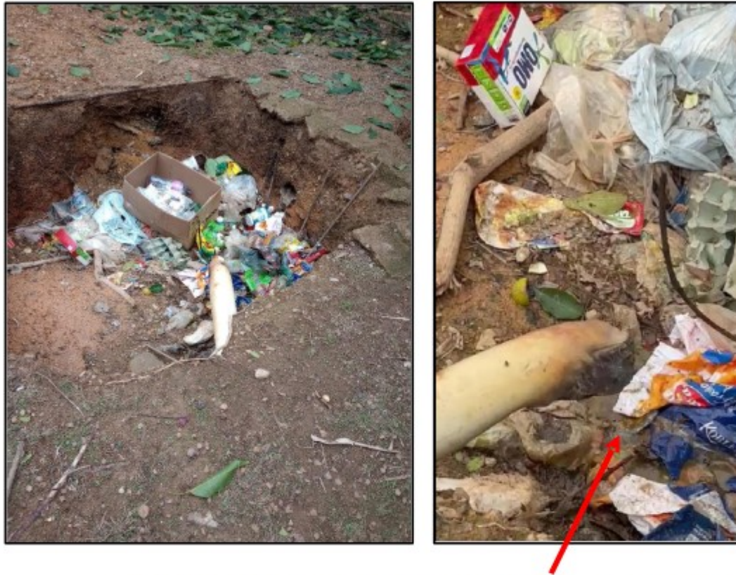
Figura 6 - Fossa séptica a céu aberto (matérias fecais saiam diretamente sobre o lixo)
