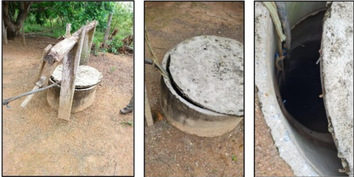
Figura 5 - Poço onde a água era captada e que ficava próximo à fossa séptica
