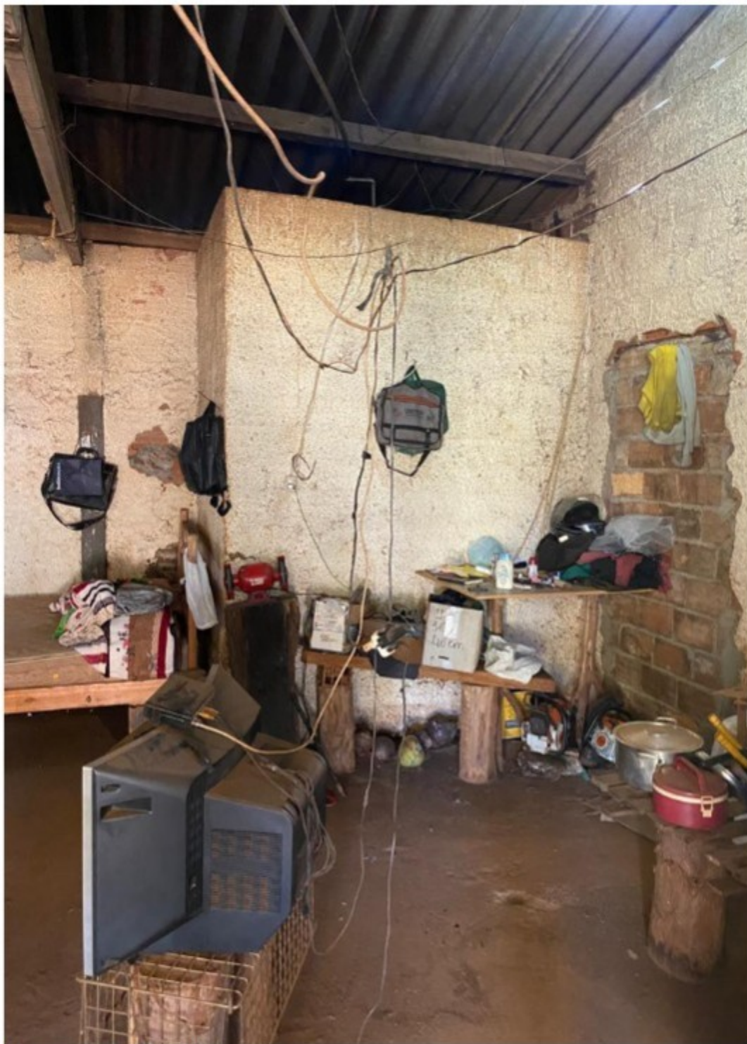
Alojamento dos trabalhadores
