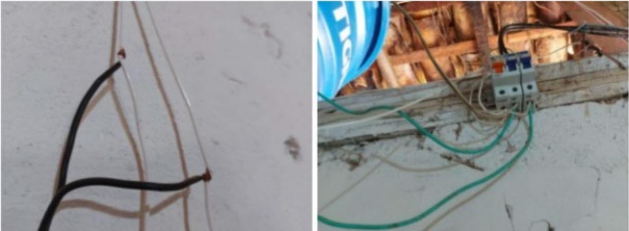
O item 31.10.1 da Norma Regulamentadora 31 determina que todas as partes das instalações elétricas devem ser mantidas de modo que seja possível prevenir por meios seguros dos perigos de choques elétricos e outros tipos de acidente, o que não foi observado pelo empregador, conforme descrito.
