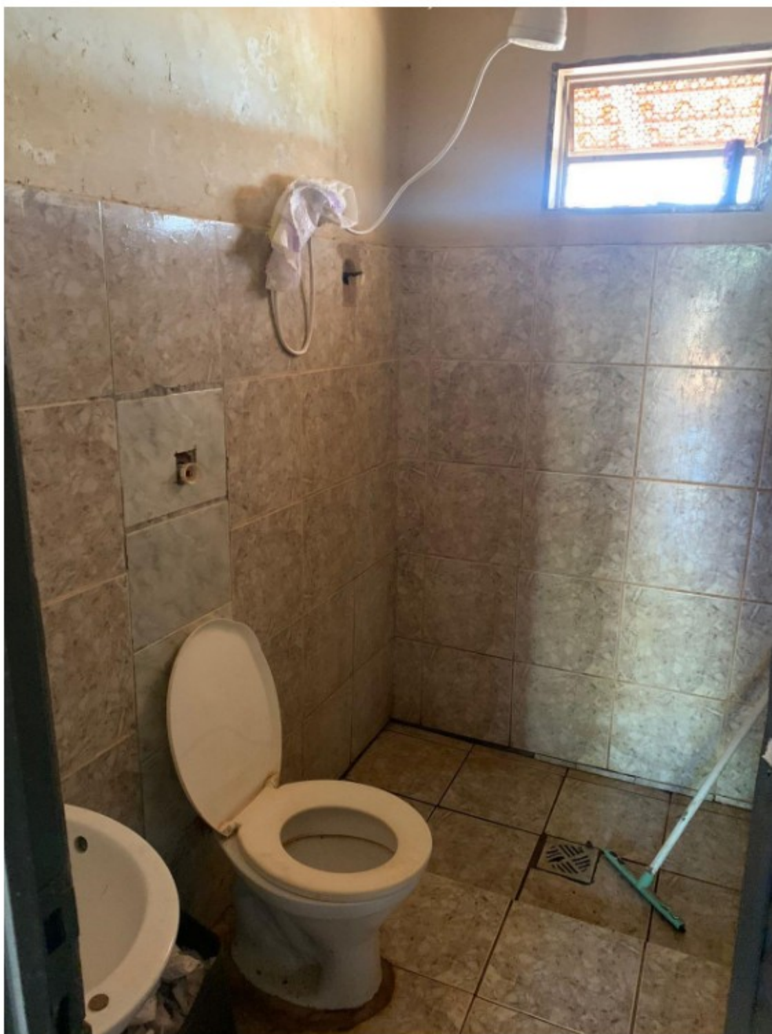
Banheiro de um dos alojamentos
