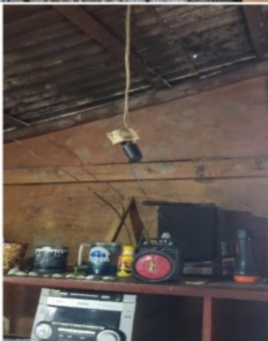
*Ligações elétricas em precárias condições e em área de possível contato*
