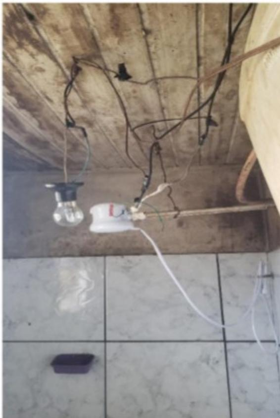
*Instalações elétricas precárias existentes por toda a habitação*
