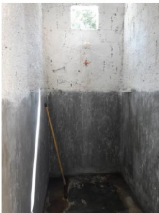
Foto 48: Interior do novo alojamento - chuveiro.
