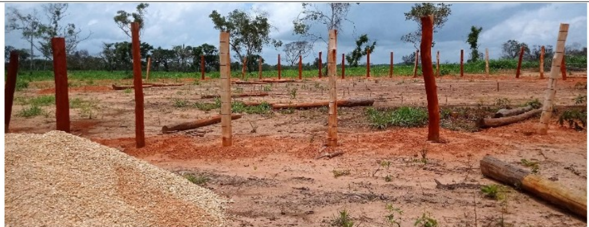
Estrutura inicial do curral em construção na fazenda Santo Antônio de Pádua
