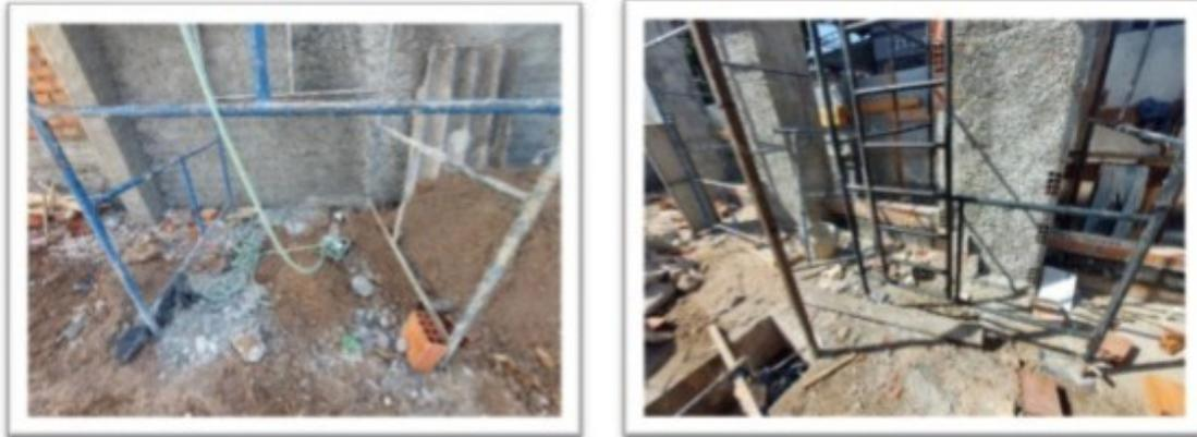
Figura 9 - Escadas sem proteção contra queda.
