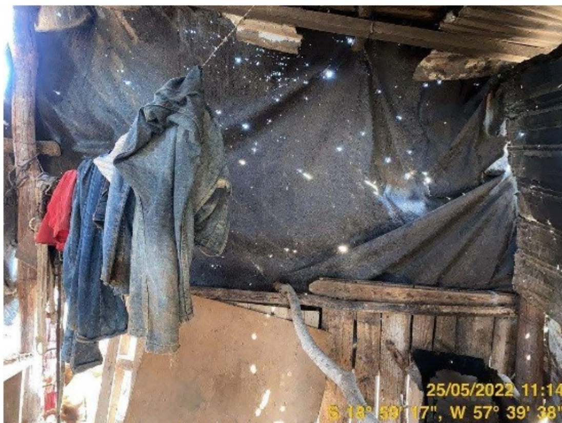
Foto 07: Interior de Estrutura Utilizada para Alojamento
