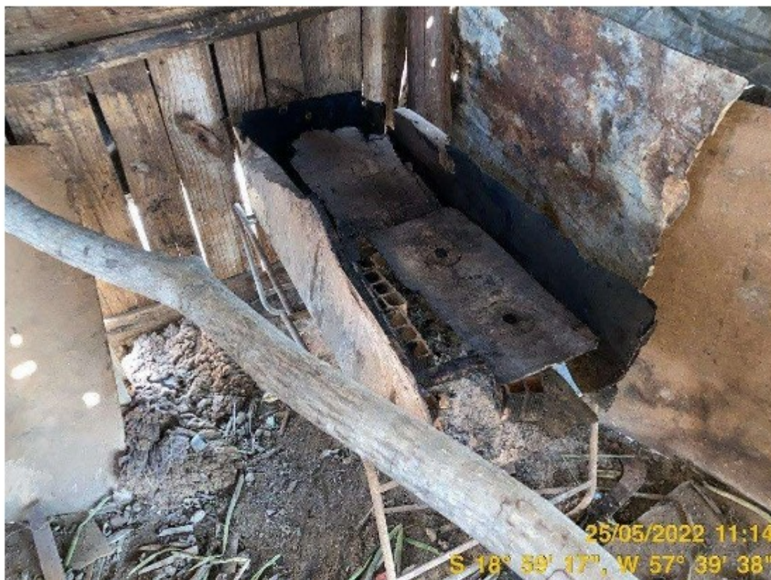
Foto 06: Local Utilizada para a Preparação de Alimentos - no Interior do Barraco
