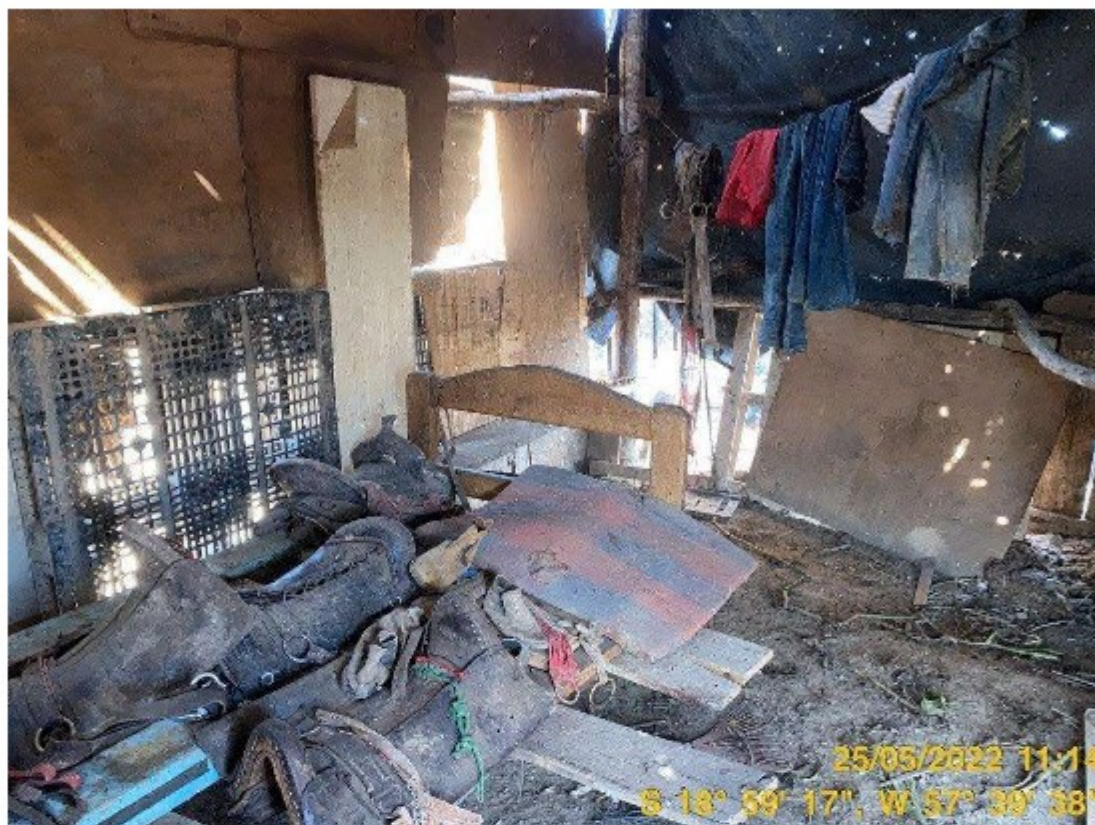
Foto 04: Interior de Estrutura Utilizada para Alojamento do Casal
