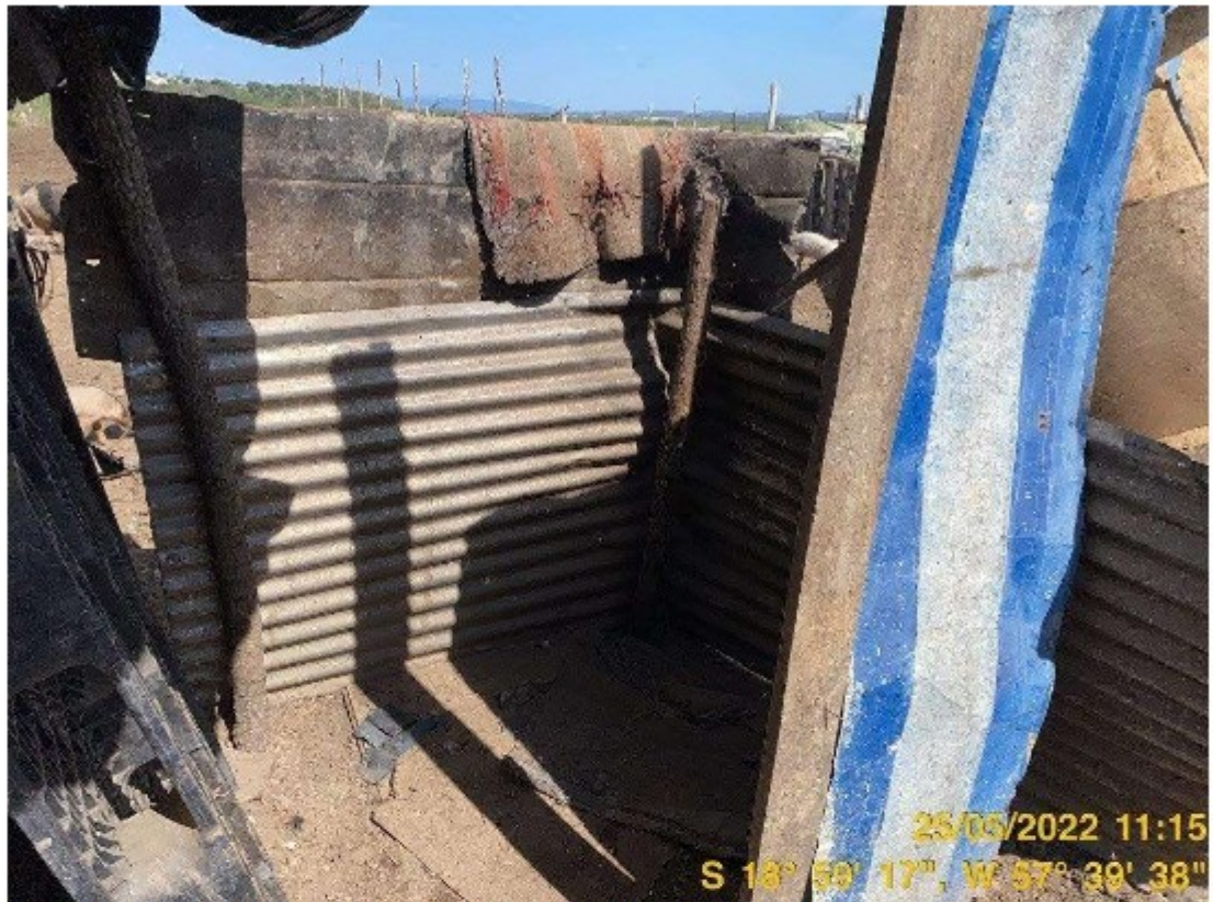
Foto 08: Interior de Estrutura Utilizada para Banho
