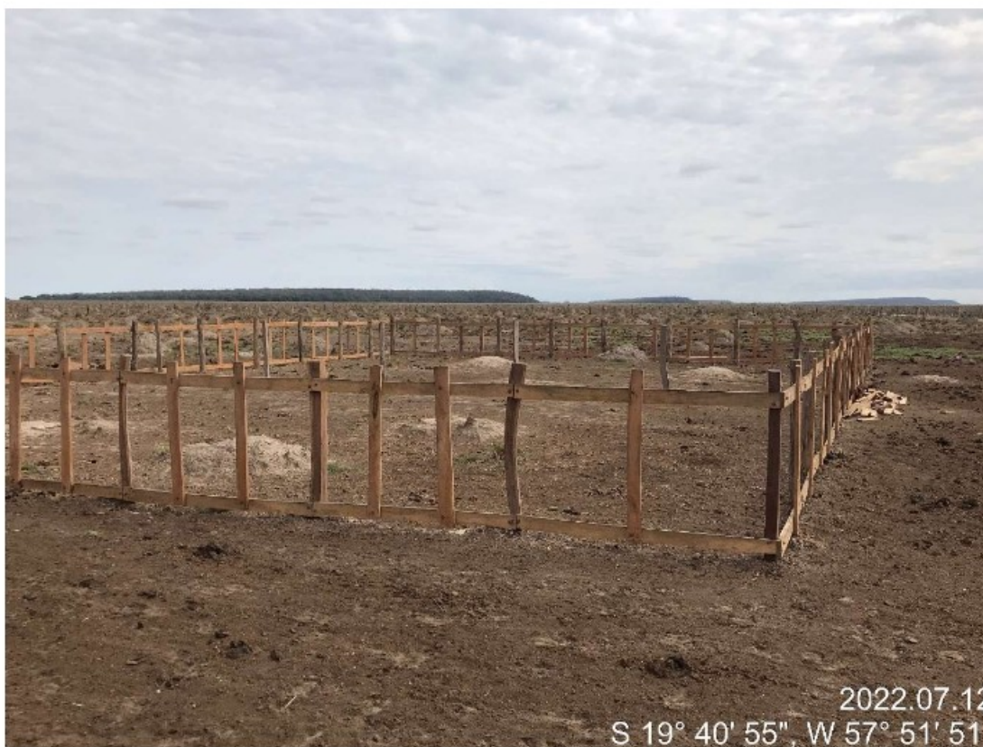
Foto 16: Frente de Trabalho
