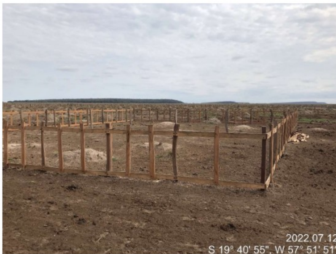
Foto 16: Frente de Trabalho
