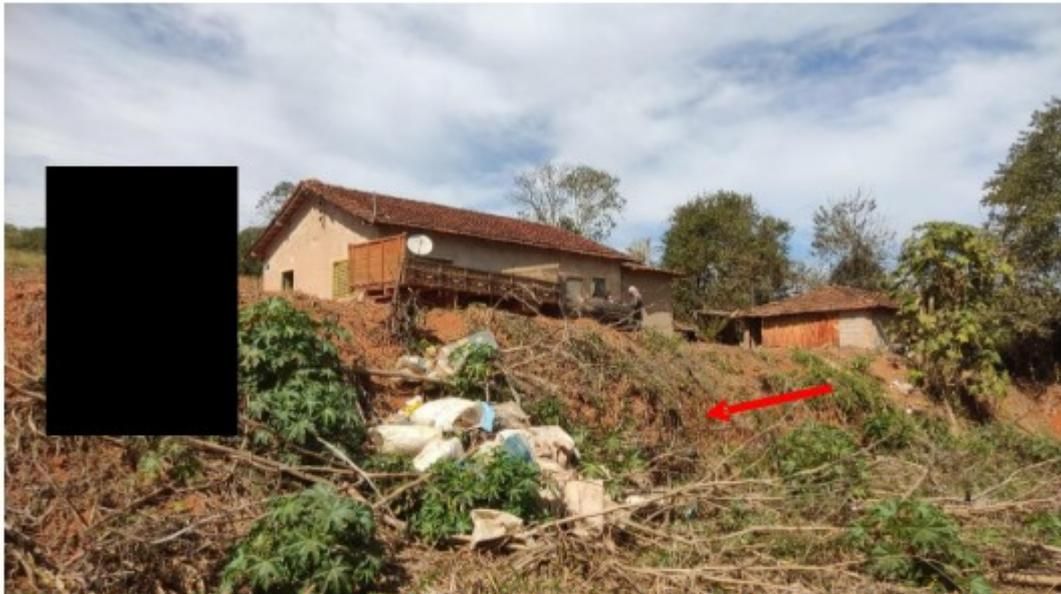
Figura 12 – Lateral noroeste da edificação. A seta vermelha aponta local, no barranco, onde tubulação proveniente do vaso sanitário despeja águas servidas contendo excrementos.
