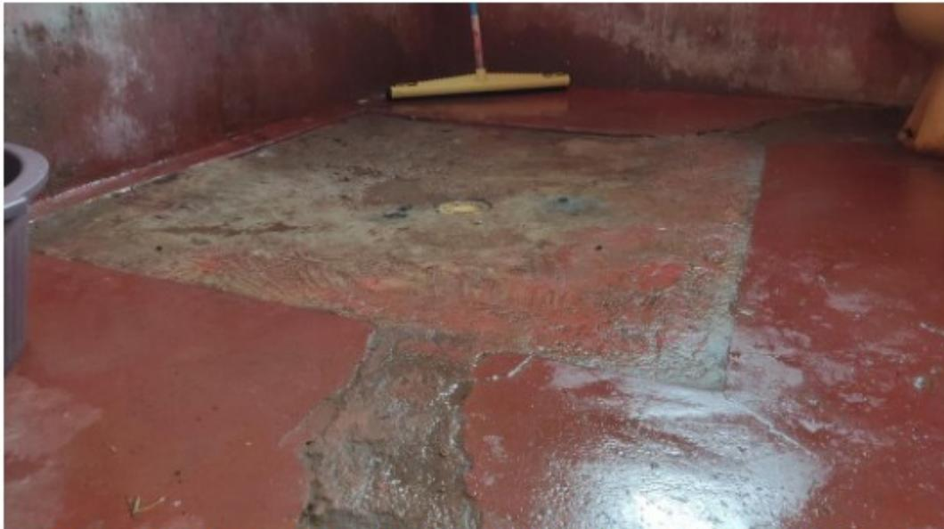
Figura 16 – Detalhe do piso sob o chuveiro. Notar o piso de cimento rugoso, que impossibilita limpeza adequada.
