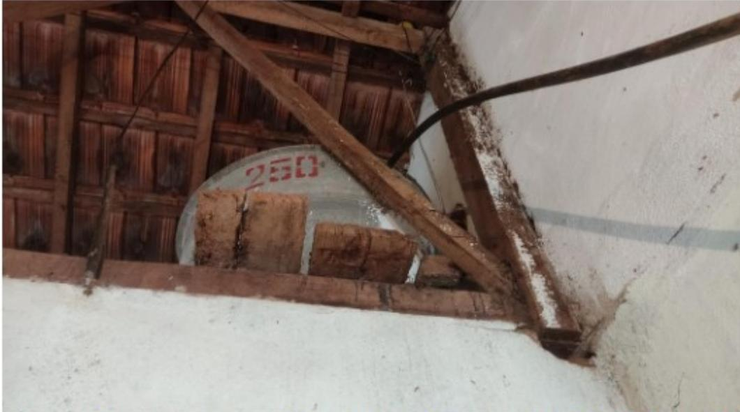
Figura 11 – Sobre um dos dormitórios, o madeiramento do telhado e de sustentação da caixa d'água repleto de poeira e teias de aranha e insetos mortos.
