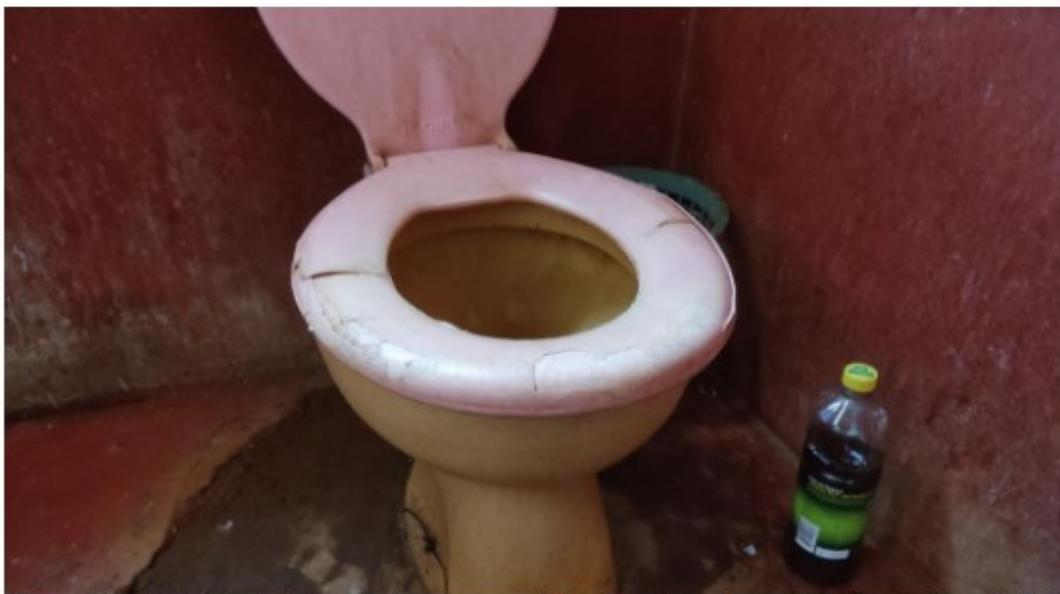
Figura 17 – Vaso sanitário do banheiro do alojamento. Notar assento rachado e quebrado, que impossibilita limpeza adequada. O piso ao seu redor encontrava-se nas mesmas condições do piso sob o chuveiro.
