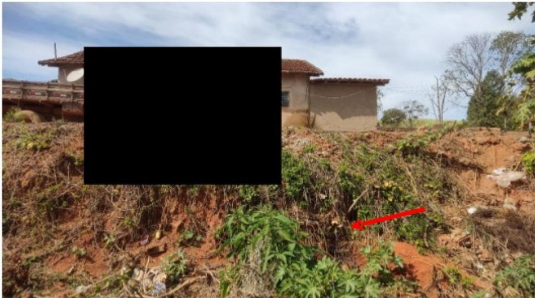
Figura 13 – Mesma lateral noroeste da edificação, com a seta vermelha apontado o despejo de águas servidas do vaso sanitário em uso.
