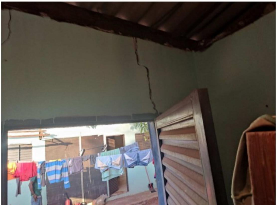
Foto 08: Paredes com Rachaduras – Alojamento
