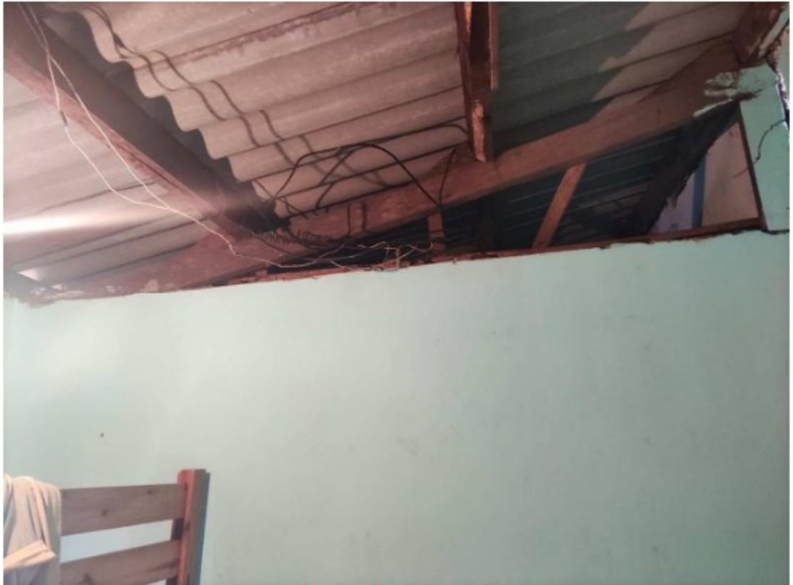
Foto 07: Fiação Exposta e Paredes com Rachaduras – Alojamento
