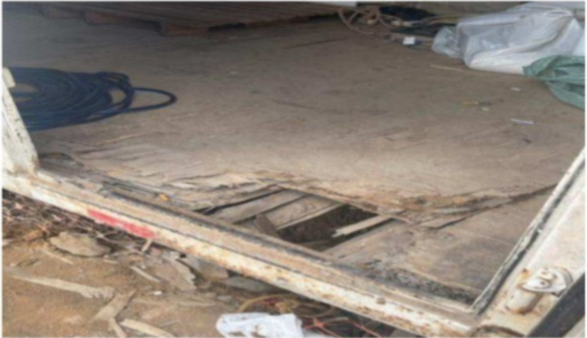
Visão de entrada do contêiner onde os trabalhadores estavam alojados.
