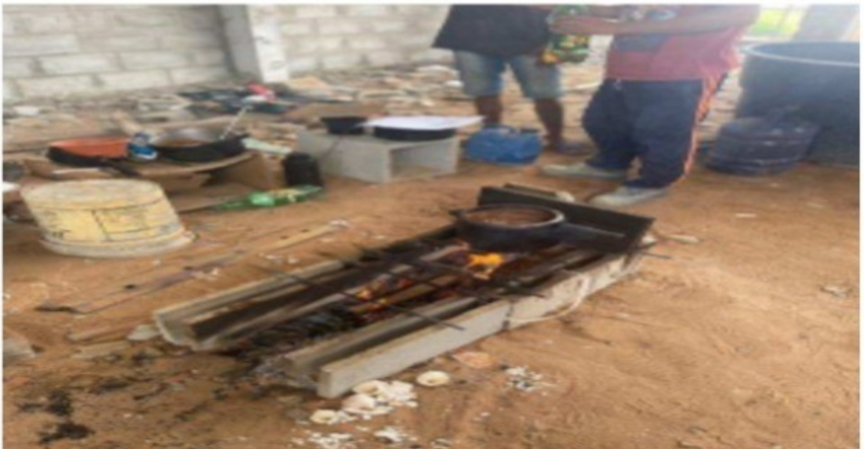
Fogão a lenha, no chão do canteiro, onde eram preparadas as refeições.
