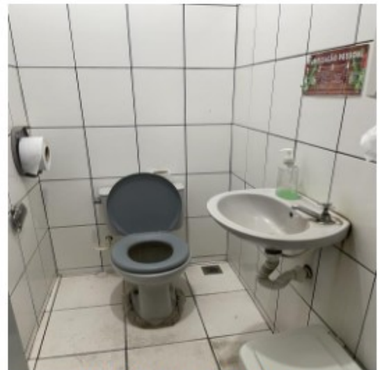
Foto 4: Interior do banheiro.
