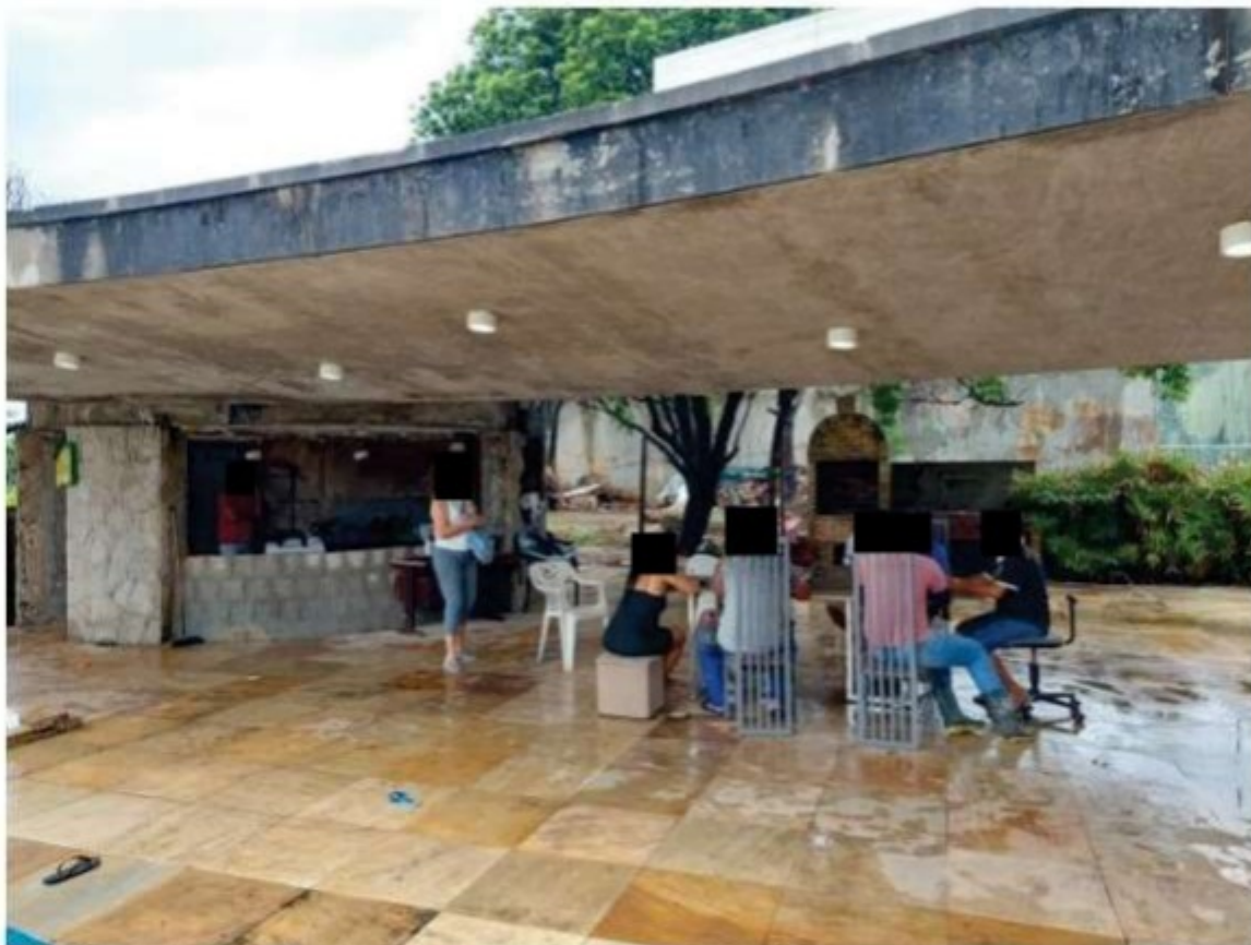
Figura 1 Trabalhadores encontrados no canteiro de obras(demolição)
