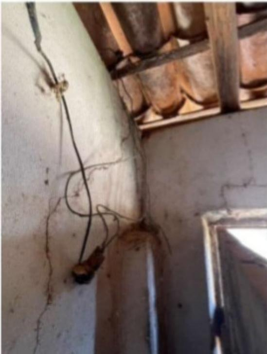
Figura 4 - Instalações elétricas precárias na sala.
