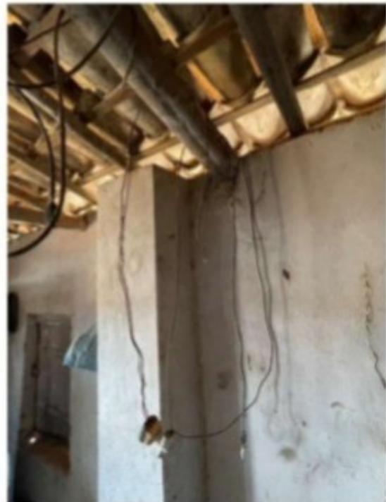
Figura 5 - Outras instalações elétricas precárias na sala.
