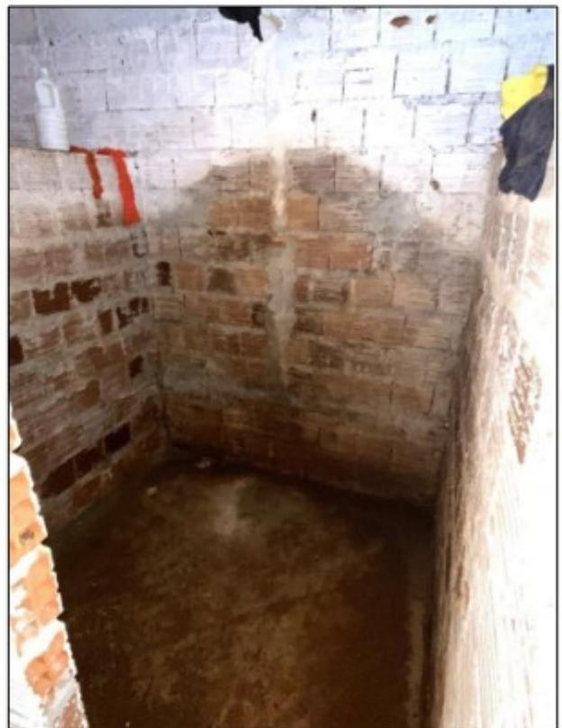
**Fotos:** Interior das instalações sanitárias. Não havia portas nos compartimentos dos chuveiros e dos vasos; não havia nenhum lavatório e nenhum mictório; não foram disponibilizados sabão ou sabonete, nem papel toalha para secagem das mãos; as paredes e o piso não eram impermeáveis e ficavam permanentemente úmidos.
