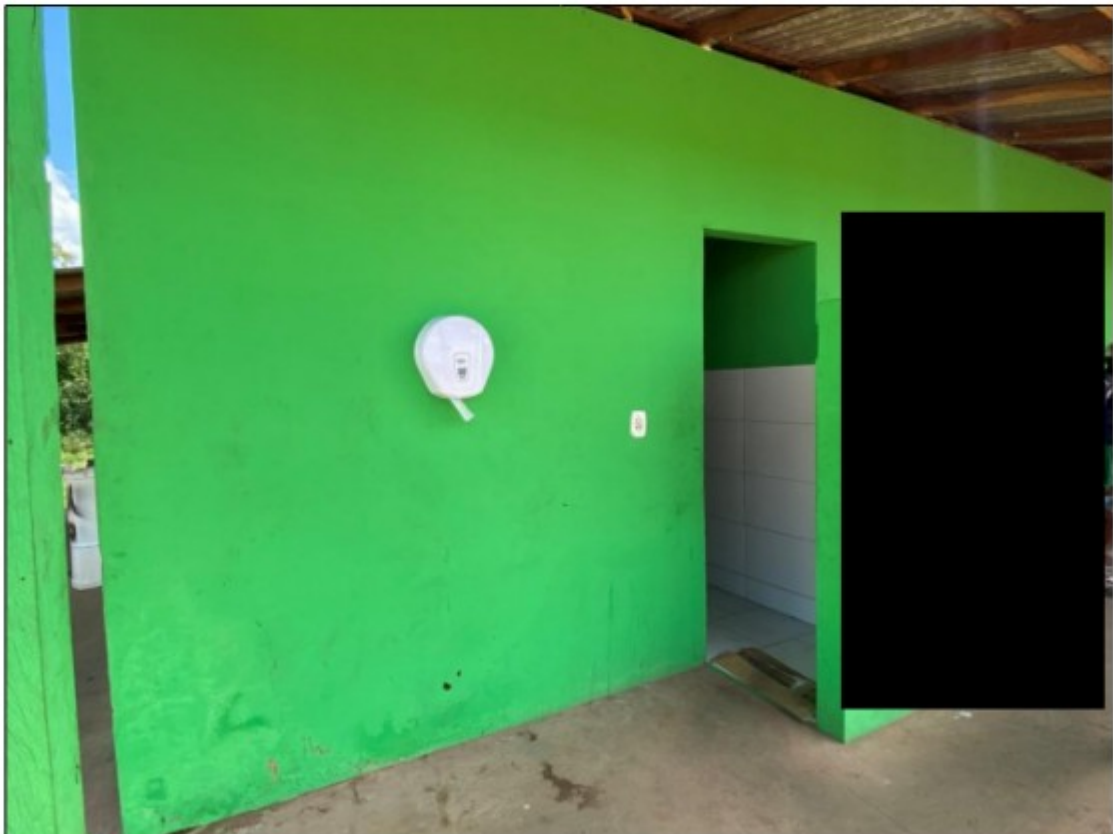
Fotos: Porta de entrada da instalação sanitária de uso coletivo, ao lado da lavanderia da edificação principal.
