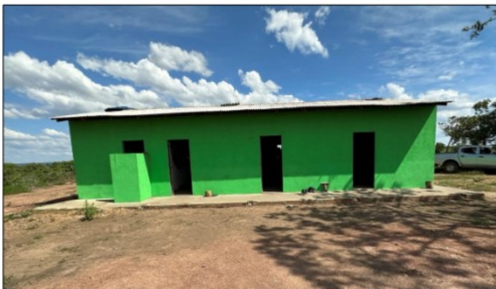
Foto: Vista externa do alojamento secundário da Carvoaria (menor), onde havia uma instalação sanitária e três dormitórios.
