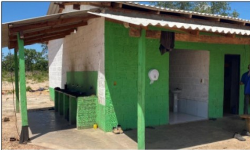
Fotos: Porta de entrada da instalação sanitária de uso coletivo, ao lado da lavanderia.
