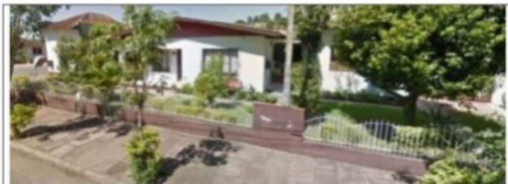
Propriedade do casal composta por três edificações interligadas: bar/ residência e garagem.
