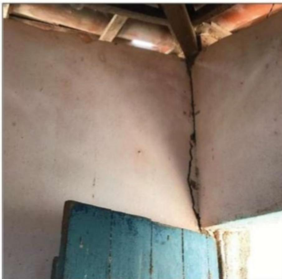
**Imagem:** Rachadura na parede do banheiro da moradia familiar dos empregados [REDACTED]
