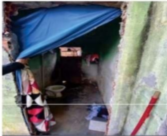
Figura 5: instalação sanitária sem porta de acesso e sem recipiente para a coleta de lixo
