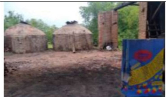
Os dois fornos utilizados na produção de carvão. Foram construídos nos fundos da edificação da antiga olaria fazendo uso dos tijolos de sua estrutura já deteriorada.
