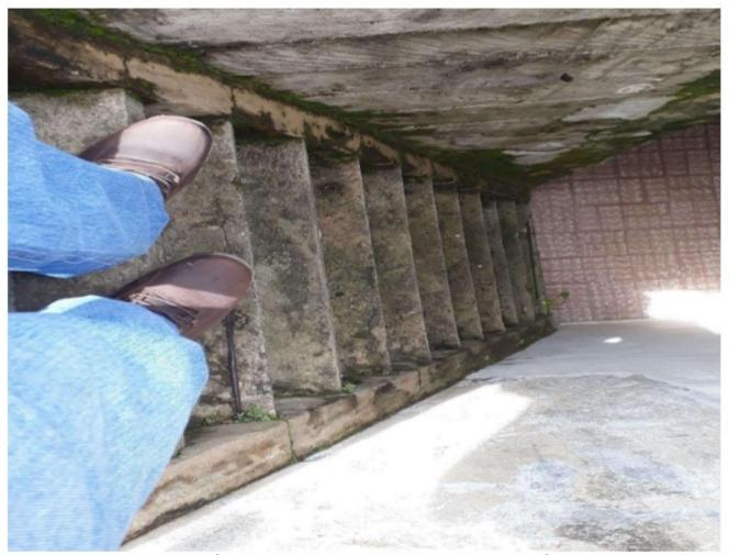
O acesso para a moradia é realizado em escada de alvenaria muito íngreme, com degraus em proporções diminutas em altura e profundidade. O risco de acidente é extremo, principalmente aos idosos.
