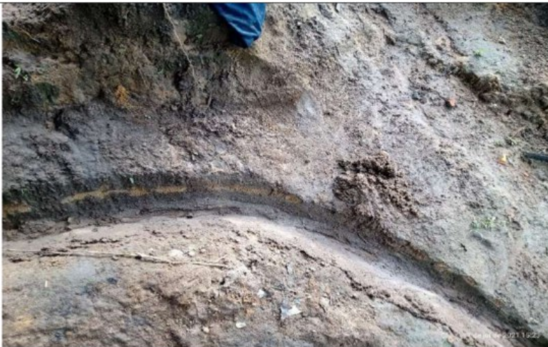
Valeta feita ao redor da moradia para escoamento da água da chuva
