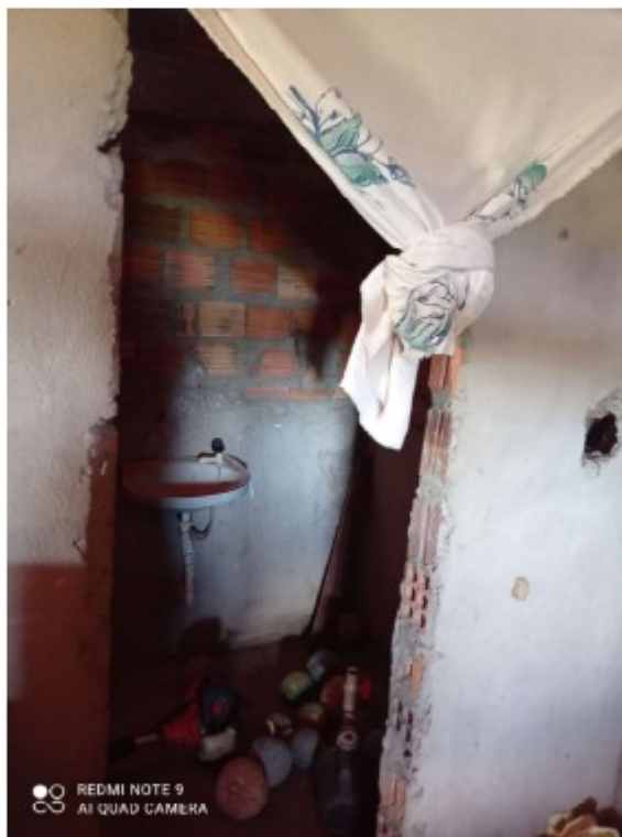
Figura: Cômodo que seria o banheiro, usado para guarda de materiais diversos.
