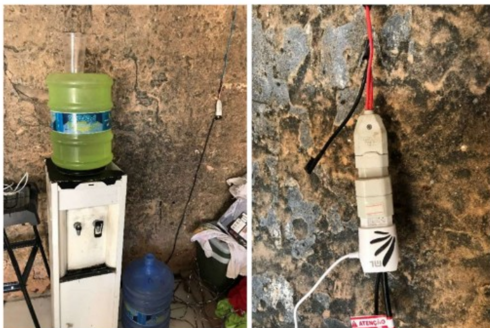
Figuras 6 e 7: Uso de copo coletivo e gambiarra elétrica na cozinha do estabelecimento.
