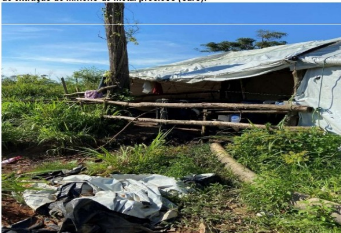
Barraco parcialmente protegido em suas laterais por lona plástica, cujo entorno é formado por mato rasteiro e sem manutenção de capina.
