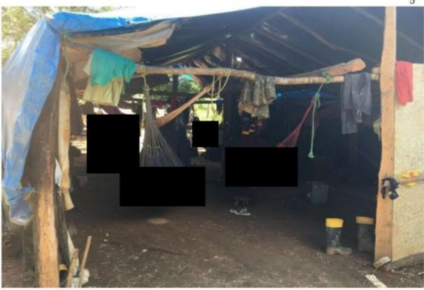
Barraco coberto de lona plástica e sustentado por caibros de madeira bruta, sem parede de proteção e piso de terra, revela a negligência do empregador para com a segurança, higiene e conforto dos empregado.
