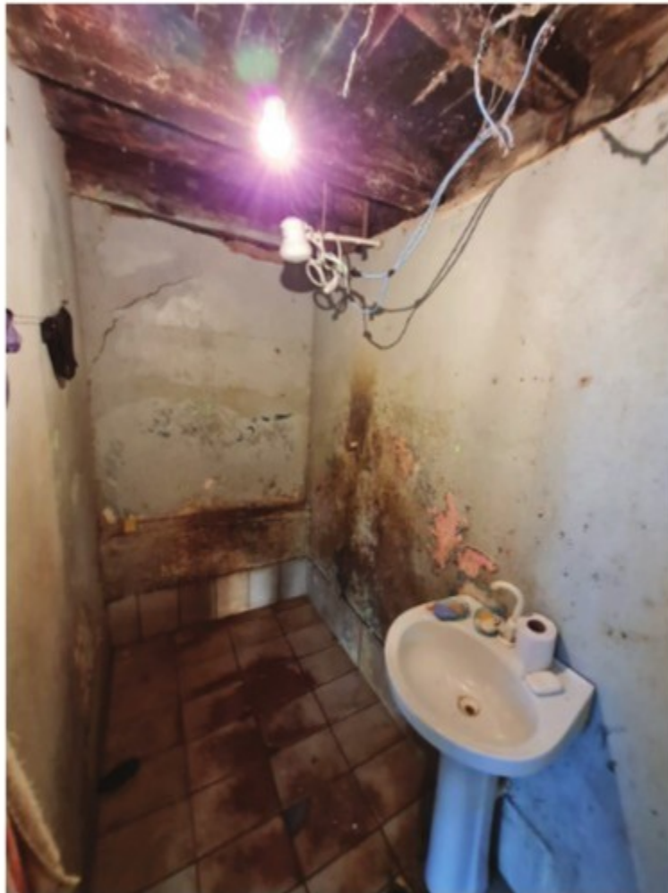
Foto de um dos banheiros utilizado pelos trabalhadores.
