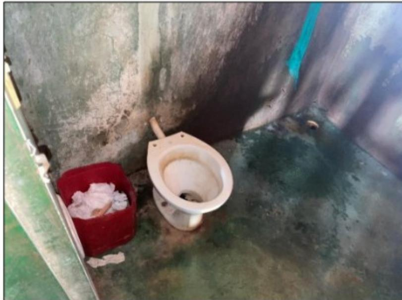
**Imagem:** Instalações sanitárias no alojamento sem condições adequadas de conservação, limpeza e higiene.
